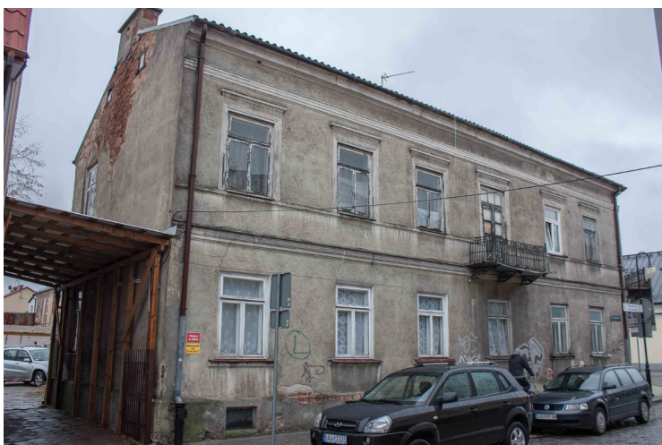
Zdjęcie nr 6 Kolejny balkon grożący zawaleniem
