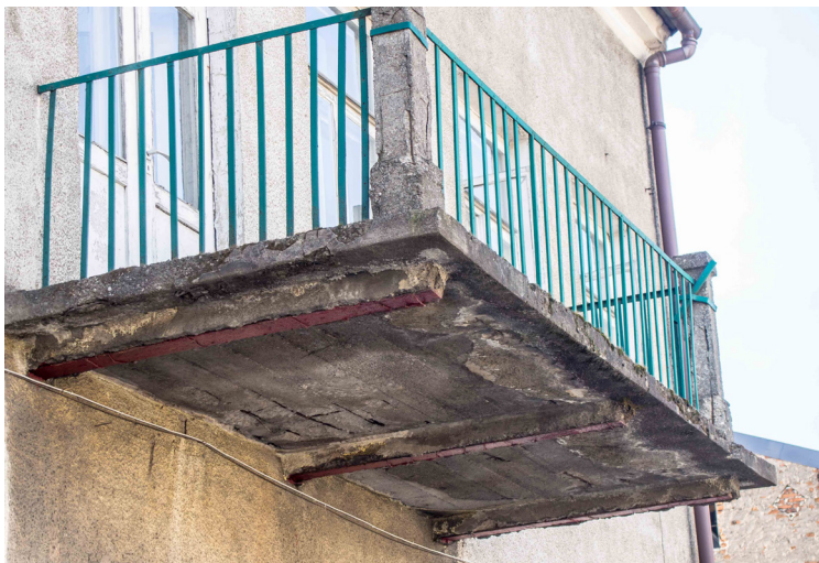
Zdjęcie nr 2 Balkon grożący zawaleniem
