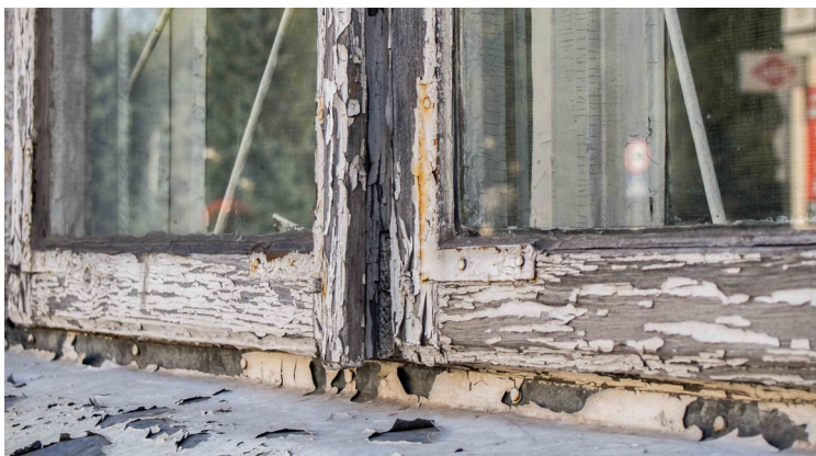
Zdjęcie nr 3 Nieszczelne i zniszczone okna
