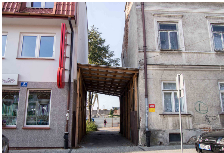
Zdjęcie nr 4 Prowizoryczne zabezpieczenie przed odpadającym tynkiem
